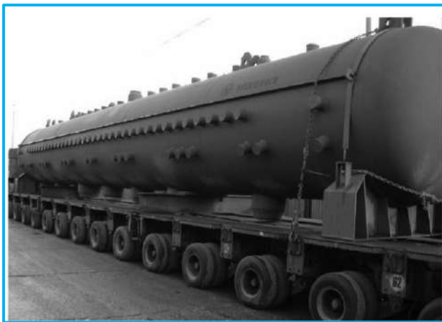
Figura 5: tambor de vapor de 20 m de comprimento e 132 toneladas a caminho do local para a caldeira de recuperação química de 6.000 tss/dia.
