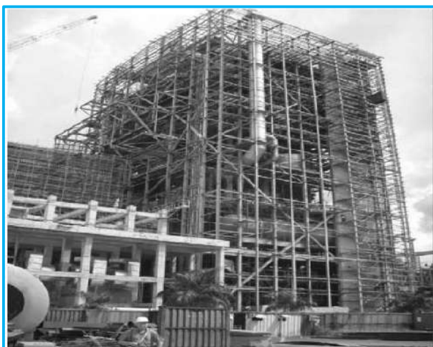
Figura 3: caldeira de recuperação de 7.000 tss/d em construção, 2009.
